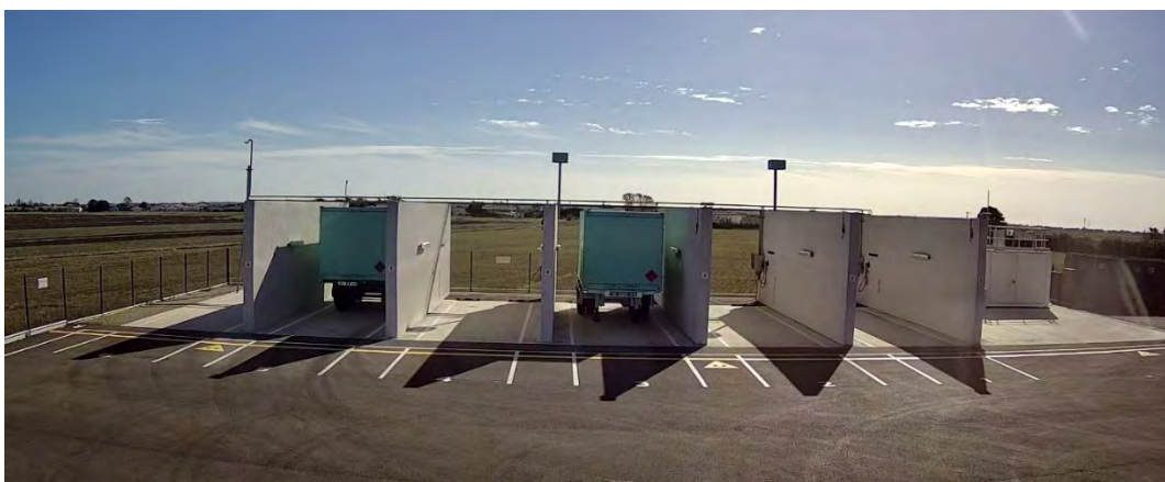
Figur 16. Exempelbild från annan befintlig anläggning för lastområde/förvaringsområde. Vätgasen avses förvaras trycksatt i separata specialbyggda containrar separerade från varandra i betongceller (Lhyfe, 2024).
