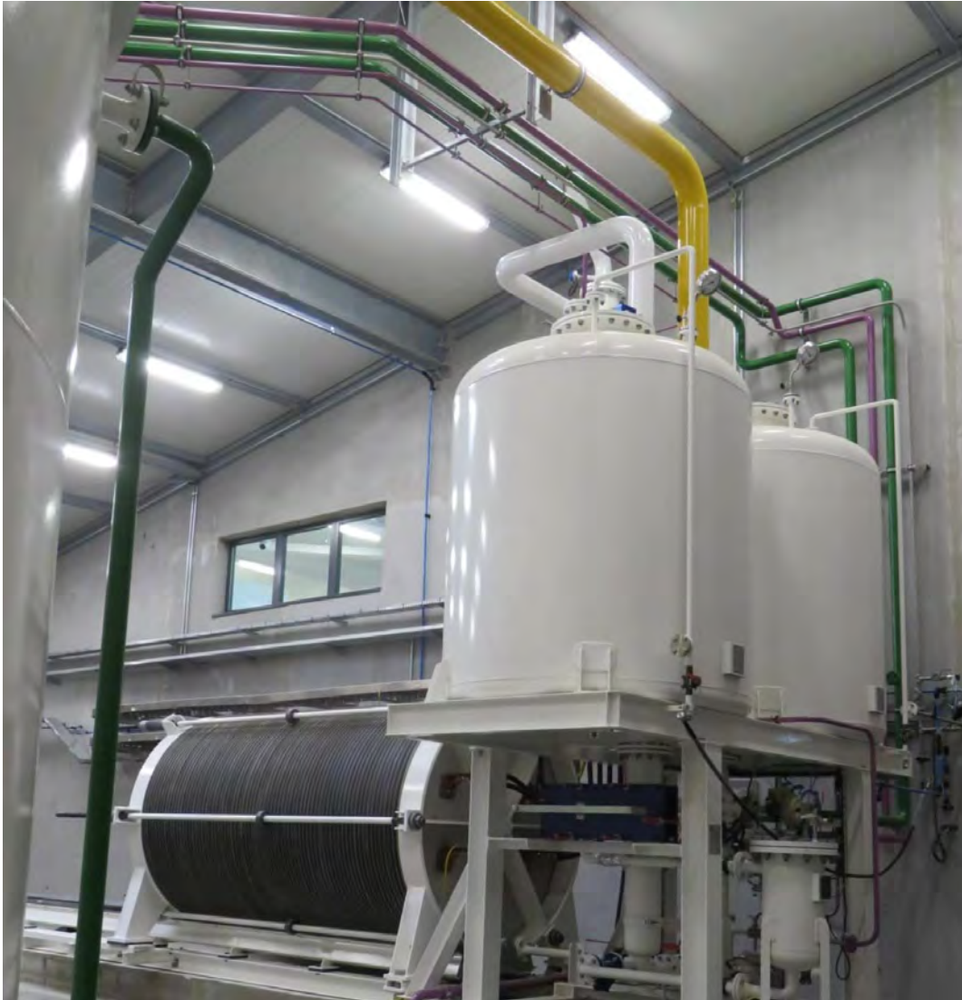
Figur 18. Exempelbild på elektrolysör från en liknande anläggning i Bouin i Frankrike (Lhyfe, u.å).
